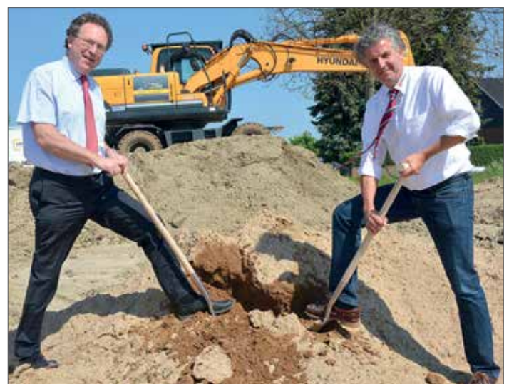
Der Helmstedter Kreisverwaltungsdirektor Wolfgang Herzog (links) und Malteser-Geschäftsführer Raphael Ebenhoch beim ersten Spatenstich am 22. Mai 2017.
